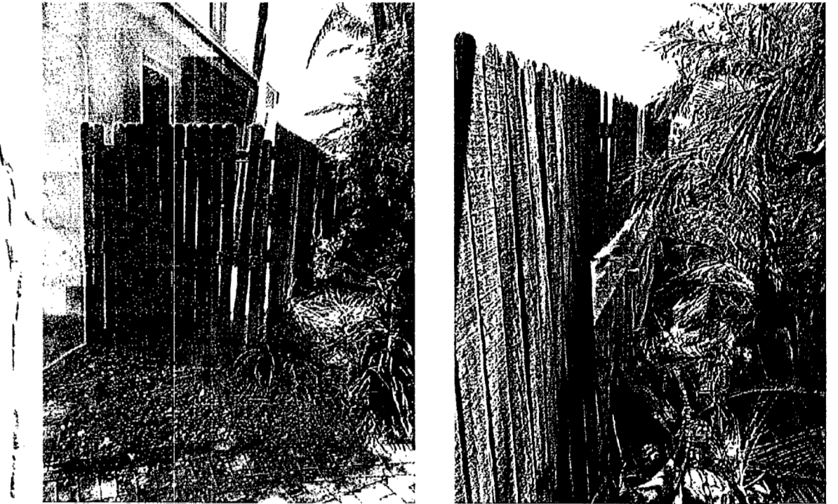
(D) EXTERIOR FENCE VIEW
