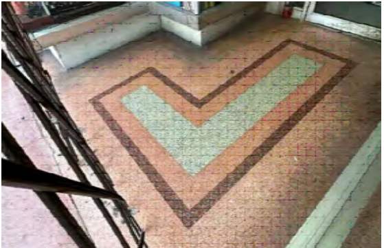
ACTUAL TERRAZO FLOORING.
