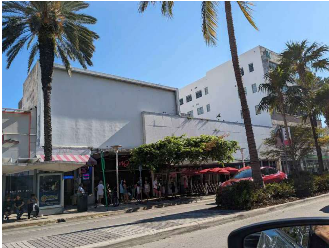
3 S.E. PHOTO N.T.S.
