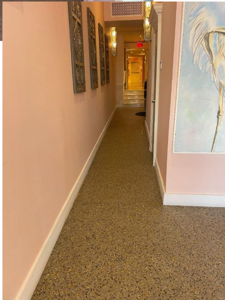
Existing Interior Tenant Sep. Wall
