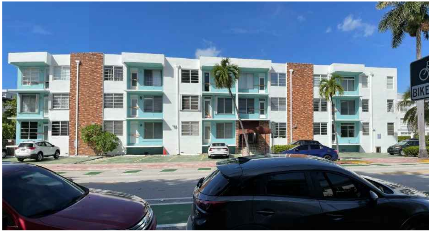
1150 EUCLID AVE. (SUBJECT BLDG.)
