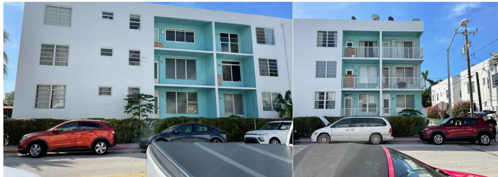
1150 EUCLID AVE. (SUBJECT BLDG.)
