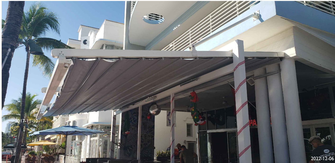
5. CANOPIES ON SITE
