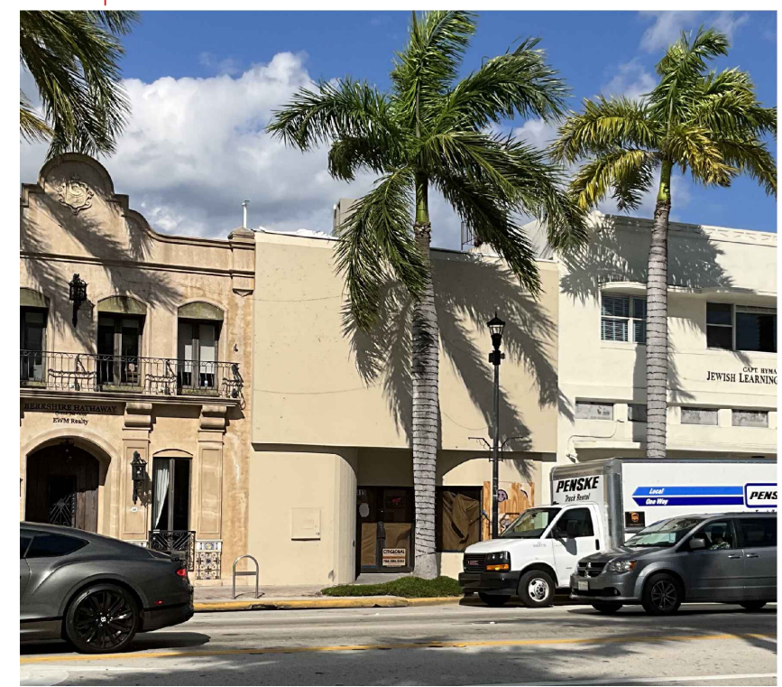
ACTUAL BUILDING PHOTO
